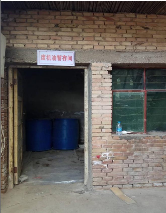
废机油暂存间
