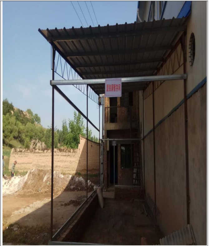
废铁屑暂存库
