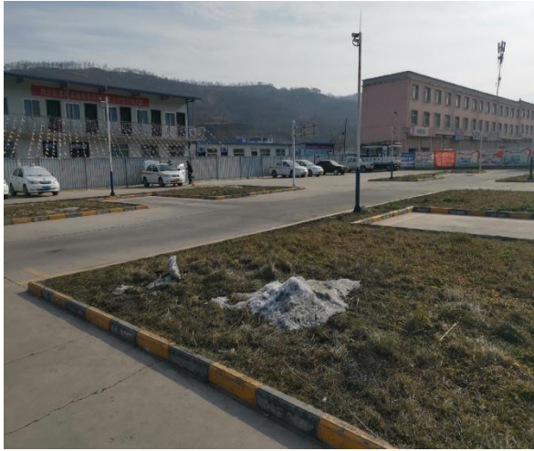
道路硬化及场区绿化
